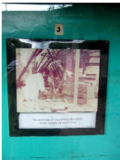
レンガの積み上げ作業
