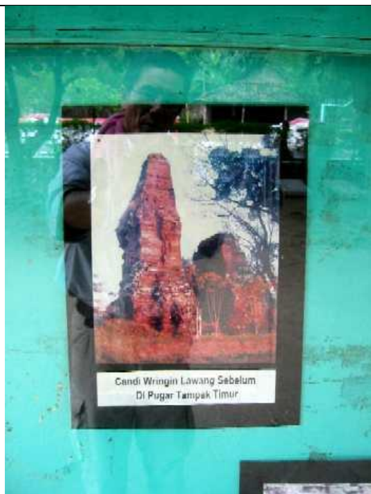
修復前の状態
