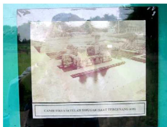
修復後水を張った状態
