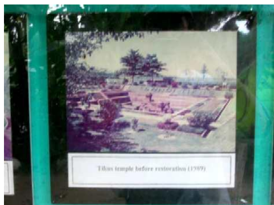
1989 年当時の復旧前の状態
