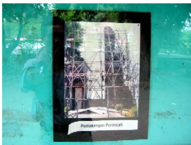
工事中の状態
