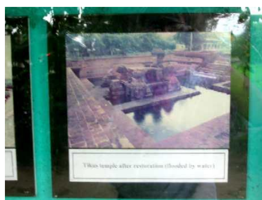
修復後水を張った状態
