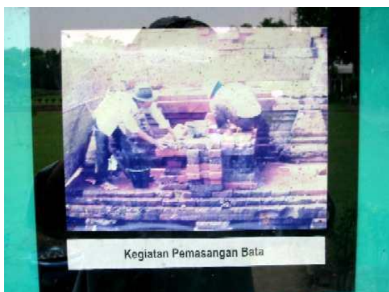
レンガの積み立て作業中
