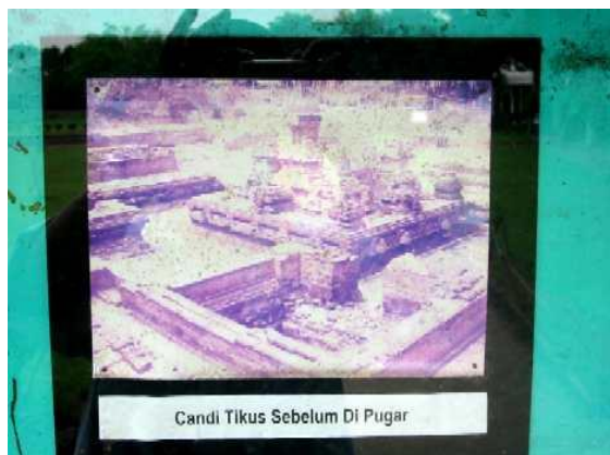
復旧前の状態
