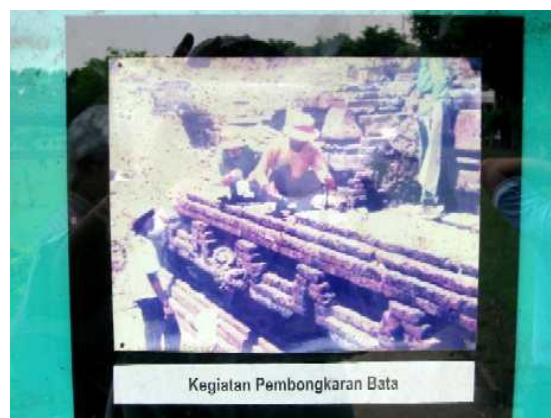
レンガの撤去作業中
